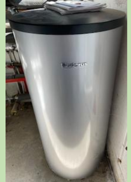
Warmwasserspeicher
