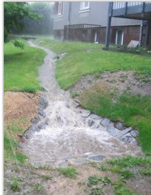
Versickerungsmulde bei Starkregen in Solingen © Kopperschmidt
