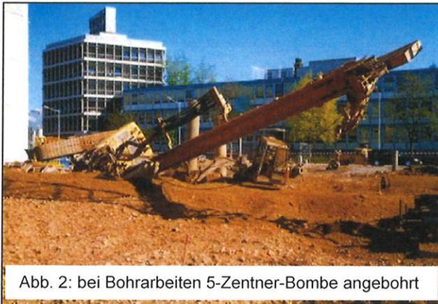
Abb. 2: bei Bohrarbeiten 5-Zentner-Bombe angebohrt
